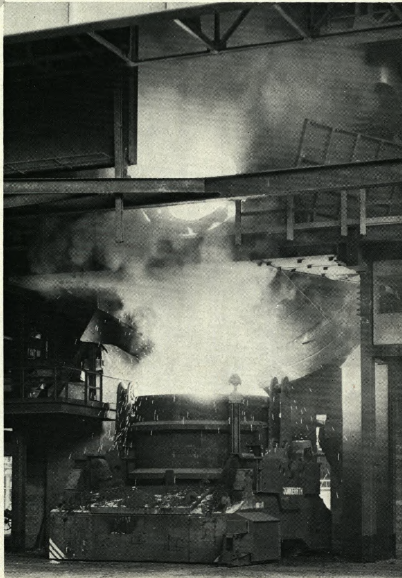
Abstich einer 175-t-Charge im LDAC-Stahlwerk.
