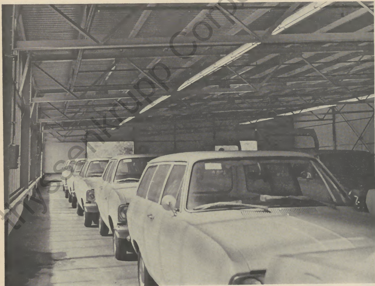
Versandhalle eines Kraftfahrzeugwerkes. Dacheindeckung mit bandverzinktem HWS-Trapezblech 40/138
