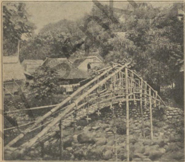
Bild 2: Bambusbrücke über den Tiliwong in Java.
