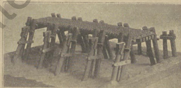
Bild 4: Modell der Jochbrücke des Julius Cäsar über den Rhein bei Koblenz, erbaut 55 v. Chr.
