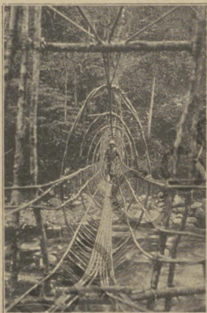
Bild 1: Rotang-Hängebrücke über den Salumano im Sakaletabo-Gebirge.
