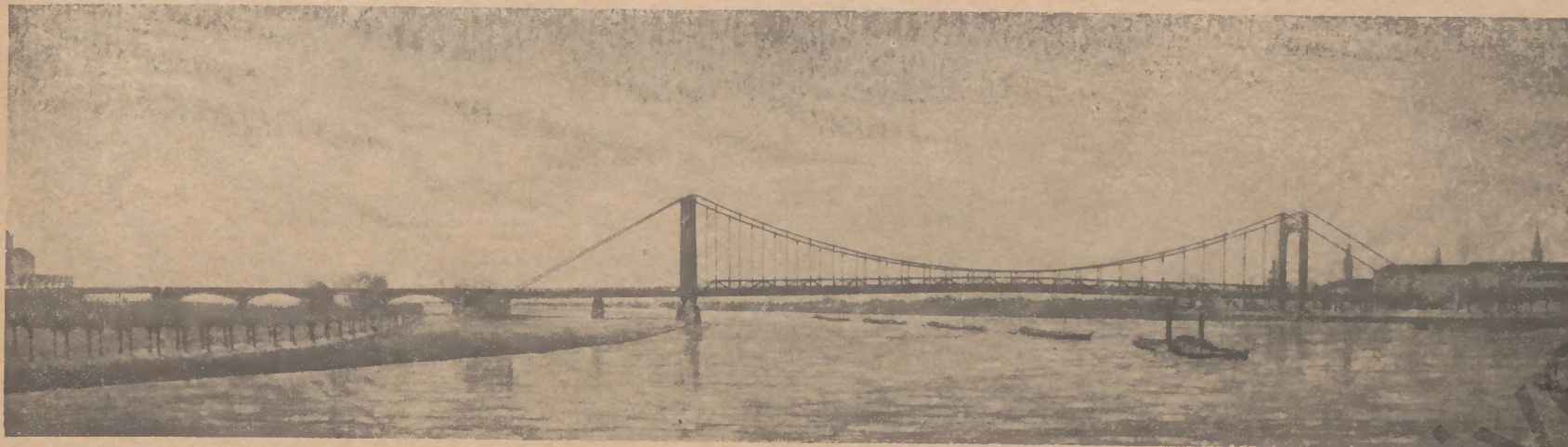
Abbildung 7. Hängebrücke mit Fachwerkversteifungsträger. Stützweite der Stromöffnung 329,0 m.
