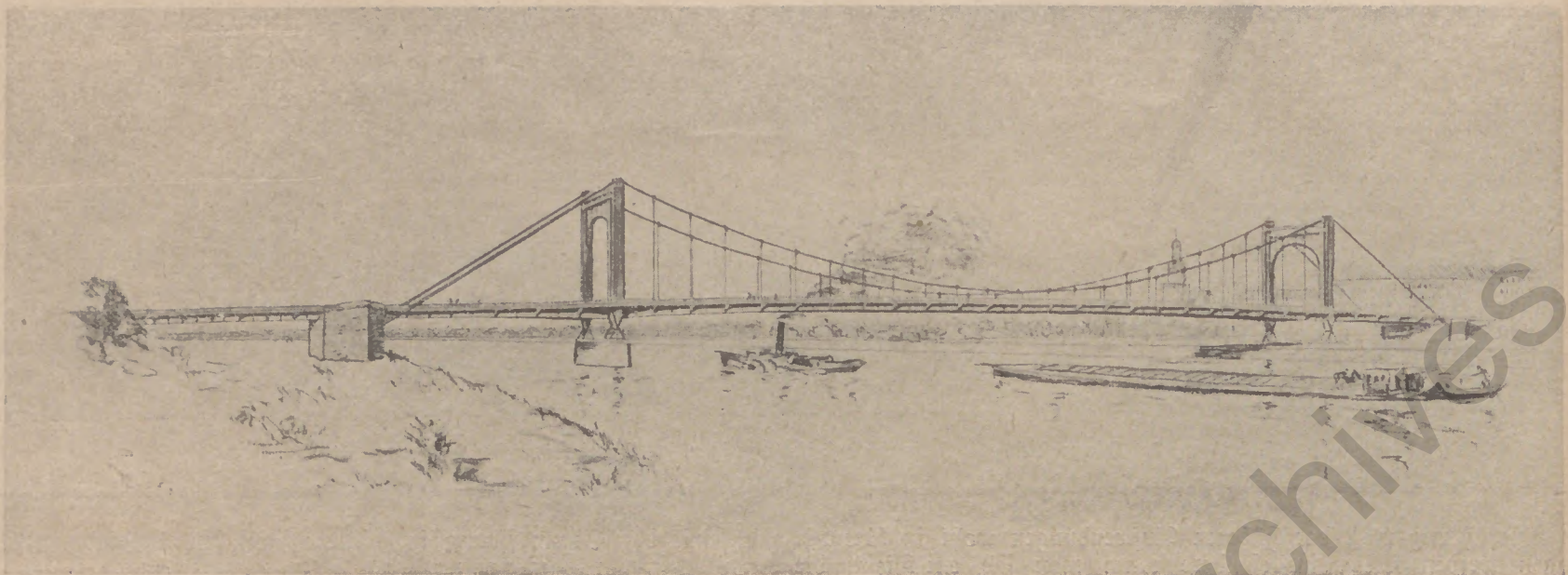
Abbildung 10. Ansicht der Hängebrücke mit Zwischenpfeiler im Strom, Stützweite der Mittelöffnung 276,0 m.
