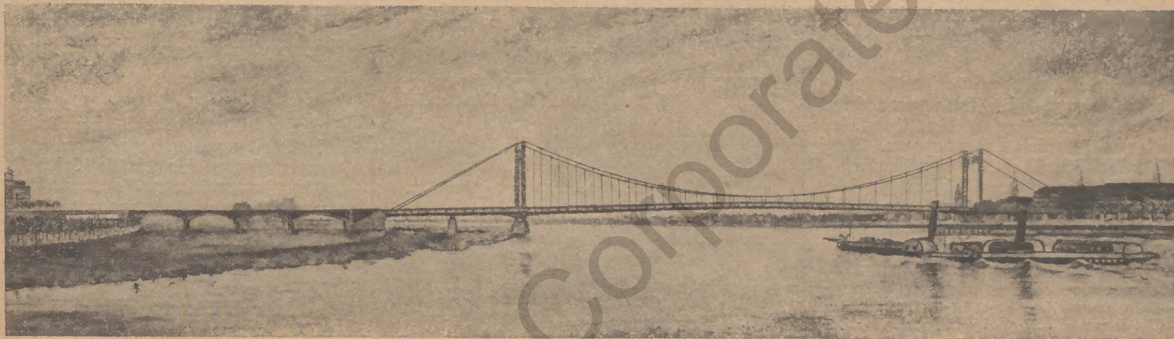
Abbildung 8. Hängebrücke mit vollwandigem Versteifungsträger.
