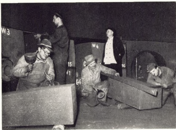
Mit der Kamera im Hochofenninnern, als der Ofen noch nicht angeblasen war. Unser Bild zeigt Meister Uhl von unserer Bauabteilung mit Spezialisten für diese Tätigkeit bei der Auskleidung der Schmelzkammer des Ofens 8 mit Kohlenstoffsteinen.
