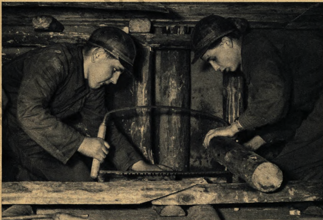
◀ Im Lehrstreb der Hoesch Bergwerks-AG schneiden die Berglehrlinge Hans Thier (links) und Paul Haarmann einen Stempel nach Maß
