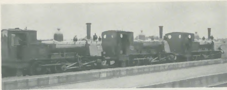
C-Tender-Lokomotiven aus dem Jahre 1911 für die damalige HSM (Hollandsch Spoorweg Maatschappij) im Bahn-Betriebswerk Doetinchem. Die mittlere Maschine ist Henschel-Erzeugnis, Fabr.-Nr. 10796.
