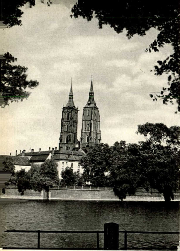
Breslau: Dombrücke und Dom
