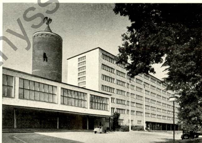
Regierungsgebäude in Oppeln
