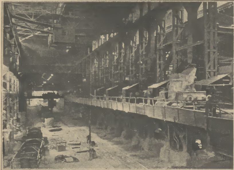
Im Thomaswerk der Dortmunder Union. Abstieg des Konverters in die Gießpfanne.
