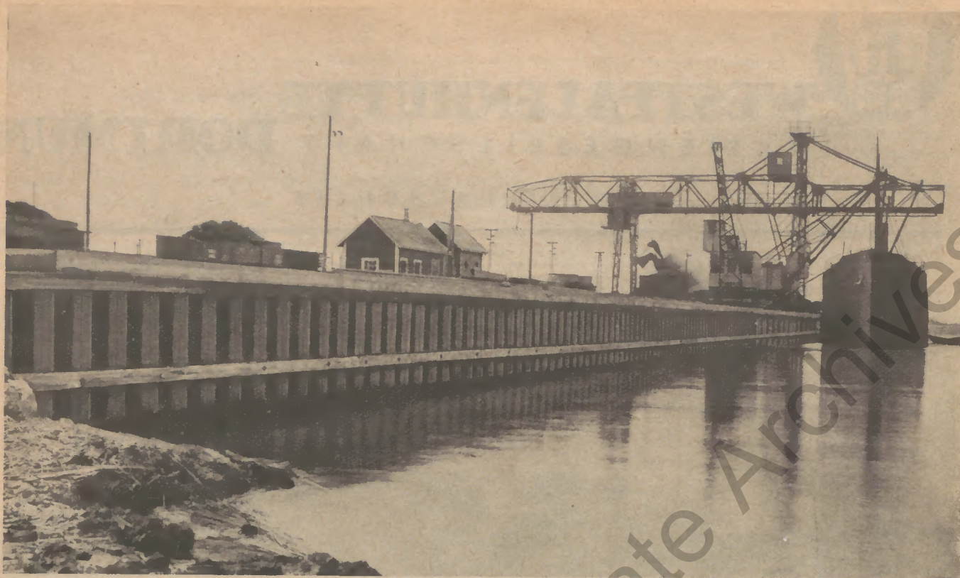
Kaiwand in Otterbaecken, Schweden, aus Stahlpundbohlen Hoesch Profil IV
