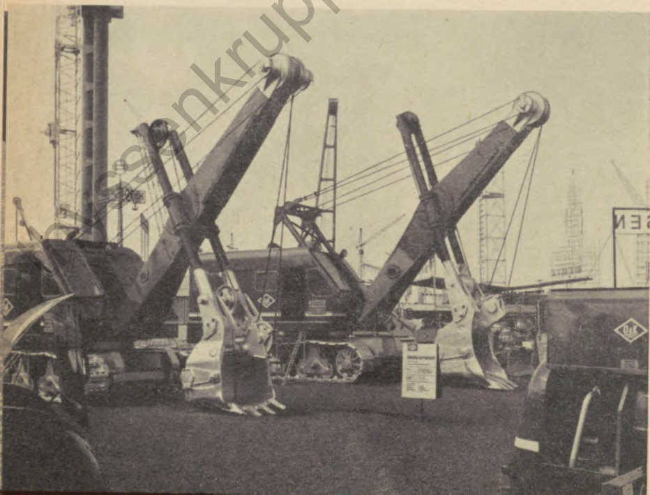
Messerwand aus BSI-Elektro- Manganhartstahl Löffelbagger der Firma Orenstein & Koppel, Bochum
