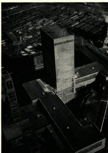
Titelseite: Ein neues Wahrzeichen für Essen nannte Bergassessor a. D. Düllberg den mächtigen, 66 Meter hohen Förderturm des Hansenschachtes, der am 23. Februar, dem 65. Geburtstag seines Namensgebers, in Betrieb genommen wurde
