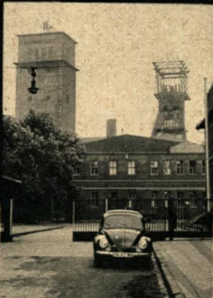
Schachanlage Kaiserstuhl in Dortmund
