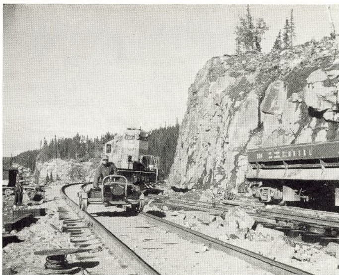
QNS & L — so steht auf den Waggonen dieser Eisenbahnlinie: Quebec North Shore and Labrador Railway. Mächtige Diesellokomotiven werden auf dieser Erzbahn eingesetzt. Unser Bild zeigt Bauarbeiten an der langen Strecke von Burnt Creek nach Seven Islands an die Seeküste
