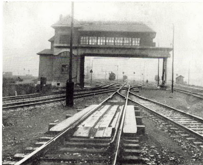
In ein Ablaufgleis eingebaute Bremse vor einem Stellwerk; fast unauffällig fügt sie sich in die Gleisanlage ein
