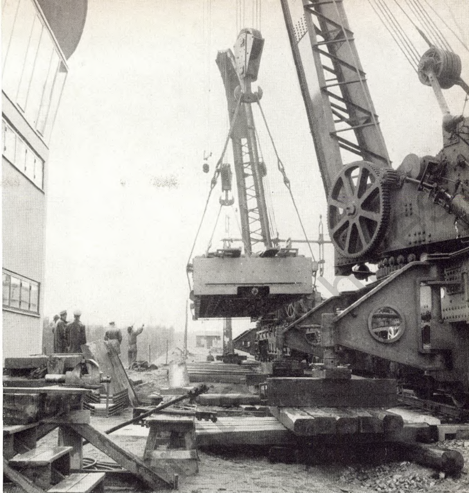
Mit mächtigen Kranwagen — auf diesem Bilde in Schweden — wird die Thyssen-Gleisbremse an der Montagestelle von den Eisenbahnwaggons gehoben und eingebaut
