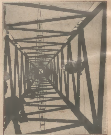
Blick in den Hochspannungsmast einer Lichtleitung
