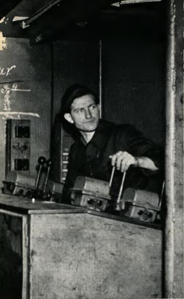
Heinz Bendrien bedient den Steuerstand am Trio-Vorgerüst
