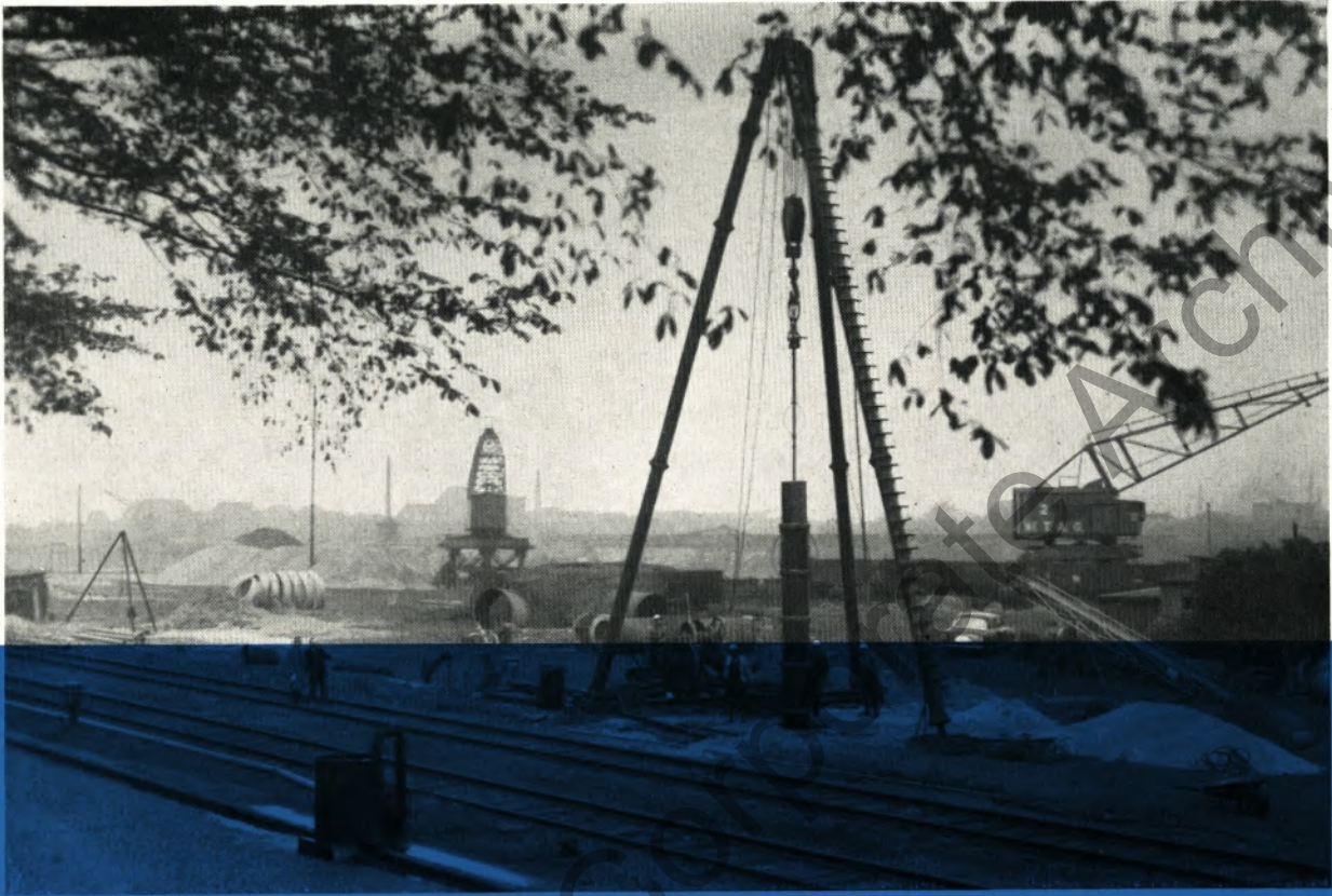
Blick auf die Bohrstelle im Gelände des Duisburg-Ruhrorter Hafens. Gerade werden die Filteraufsatzrohre in die Brunnenbohrung eingebaut. Im Vordergrund erkennt man das Meßtaugefäß
