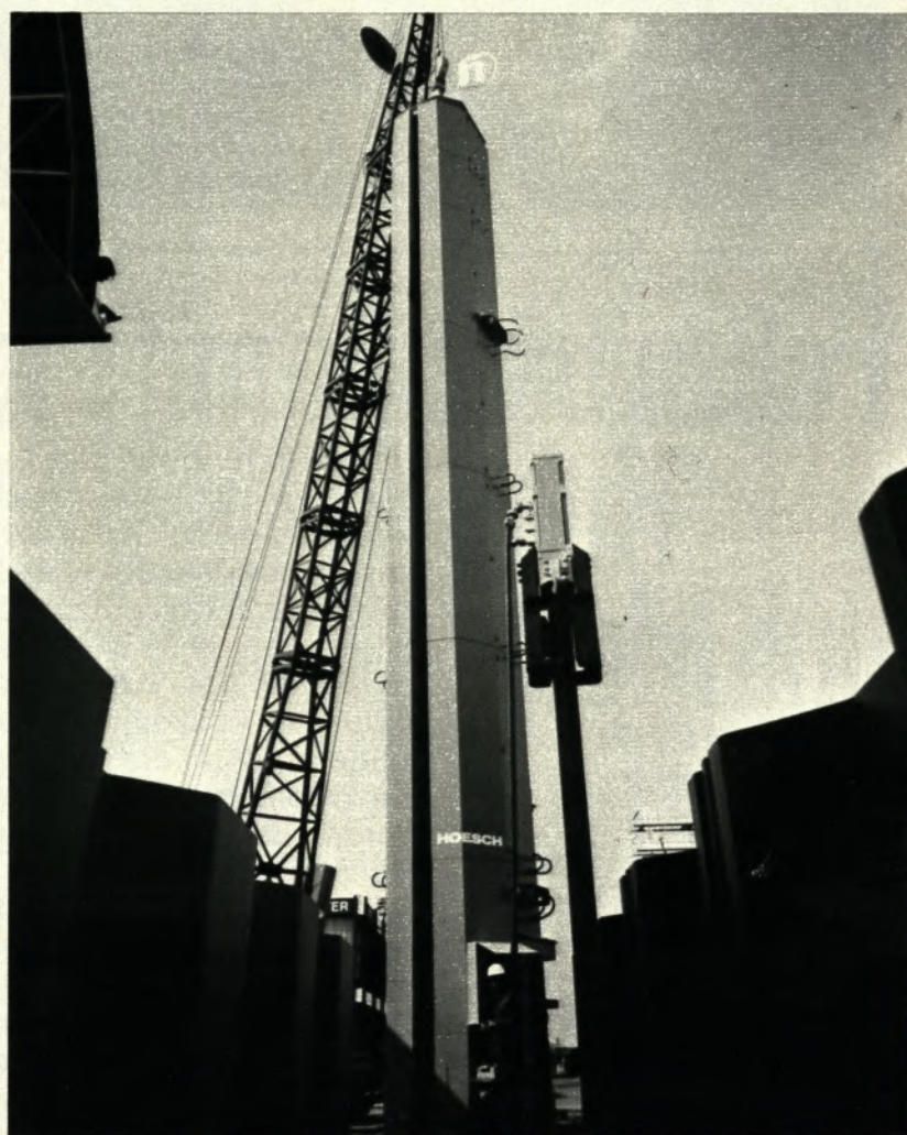
Blick auf das Hoesch-Messehaus: links Hoesch-Rohre mit Platal-Verkleidungen, die der Wärmeisolation dienen — rechts der Lärmschutzturm, der den Lärm beim Hammen von Stahlspondbohlen entscheidend mindert
