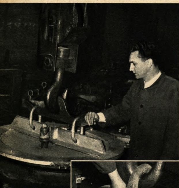
Günter Lemke hat einen neuen Tragschwengel für Glühtöpfe konstruiert (oben), der die Quetsch- und Klemmgefahr beseitigt (rechts)
