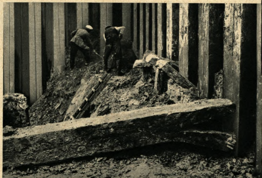
Spundbohlen durchschlagen fast alle Hindernisse
