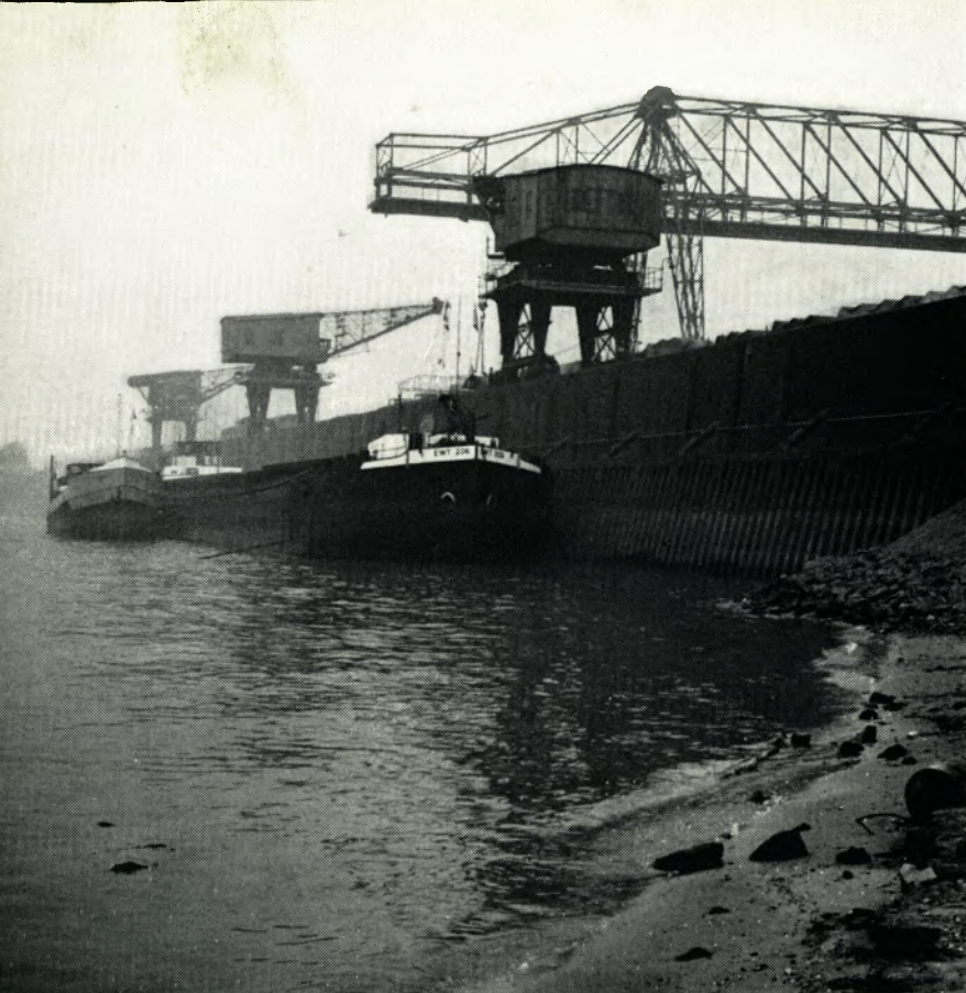
Der Rhein hat seit Wochen einen Niedrigwasserstand, wie er seit Jahren nicht mehr vorgekommen ist. Schwierigkeiten in der Erzversorgung und erhebliche Verteuerungen der Frachten für den Wasserweg sind die Folge. Unser Foto wurde am Rheinufer des Hafens Schwelgern aufgenommen und zeigt deutlich den gesunkenen Wasserspiegel.
