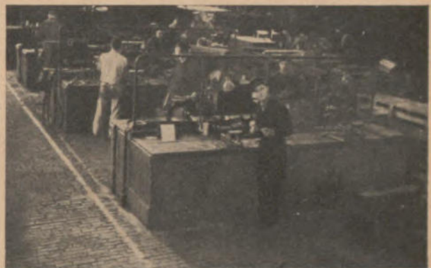
Blick in die Lokomotivwerkstatt mit den Werkbänken
