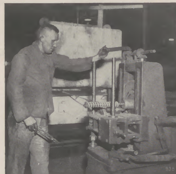
Abb. 21: Eine Schraubenfeder von kleinem Windungsdurchmesser wird gewickelt. Die Wickelmaschine steht unmittelbar vor dem Ofen
