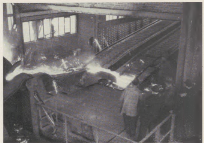
Vergießen von Roheisen auf der neuen Masselgießmaschine
