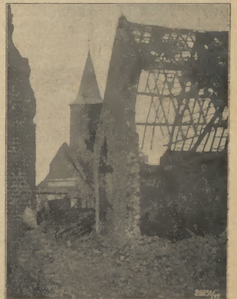
Durch englisches Artilleriefeuer zerstört und von den Franzosen verlassener Teil des Dorfes B. an der Straße nach Carion
