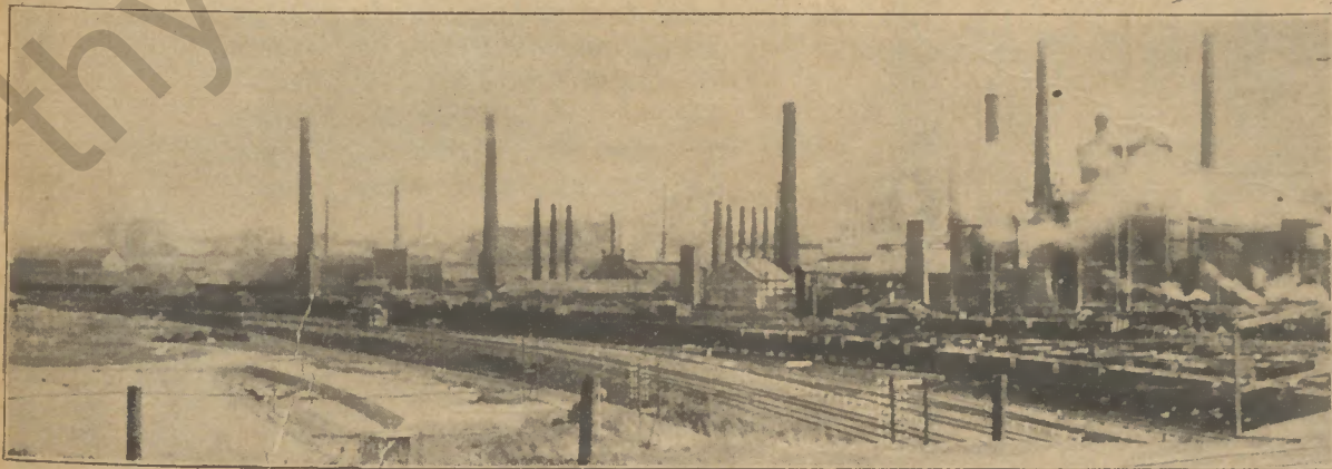
Gesamtansicht der Dortmunder Union aus den 90er Jahren, von der Köln-Mindener Bahnseite aus gesehen.
