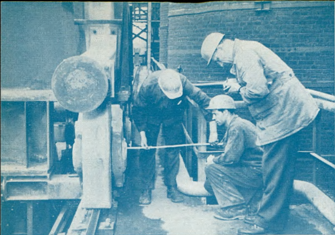
Die Arbeitsschutzstellen sind dauernd unterwegs, um Unfallquellen aufzuspüren. Hier wird geprüft, ob Quetschgefahr durch den Kran besteht.
