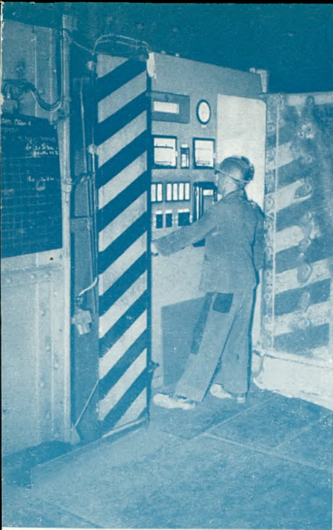
Schwarz-gelbe Warnstreifen zeigen akute Gefahr an, hier Quetschgefahr durch Chargierkran auf einer Ofenbühne im Martinwerk.
