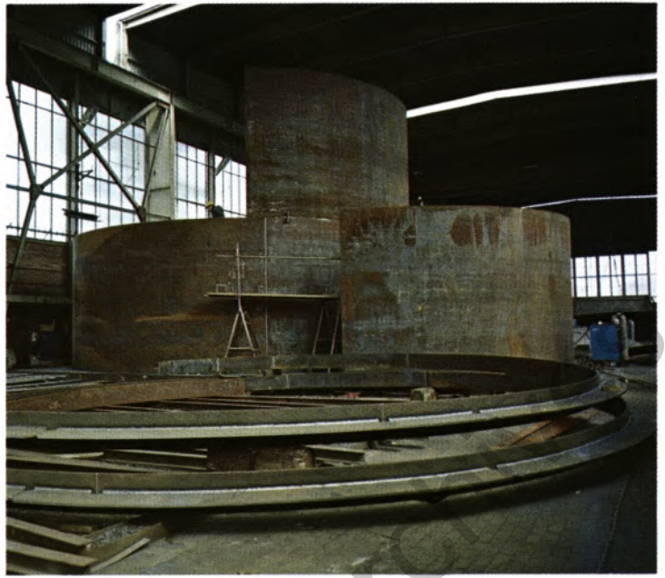
Fertigung der Tankanschlüsse.
