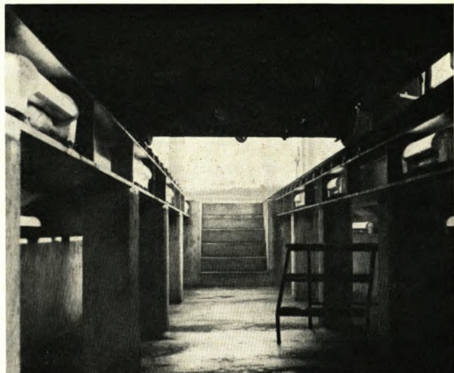
Die Untersuchungsgrube für Loks beim Hüttenbetrieb Meiderich wurde fertiggestellt.
