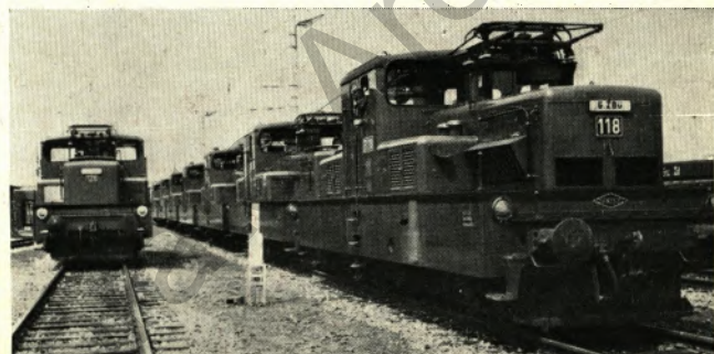
Schichtwechsel vor dem Lokschuppen in Bruckhausen. Moderne Elloks mit Dieselhilfsantrieb sind an die Stelle der alten Dampfloks getreten.
