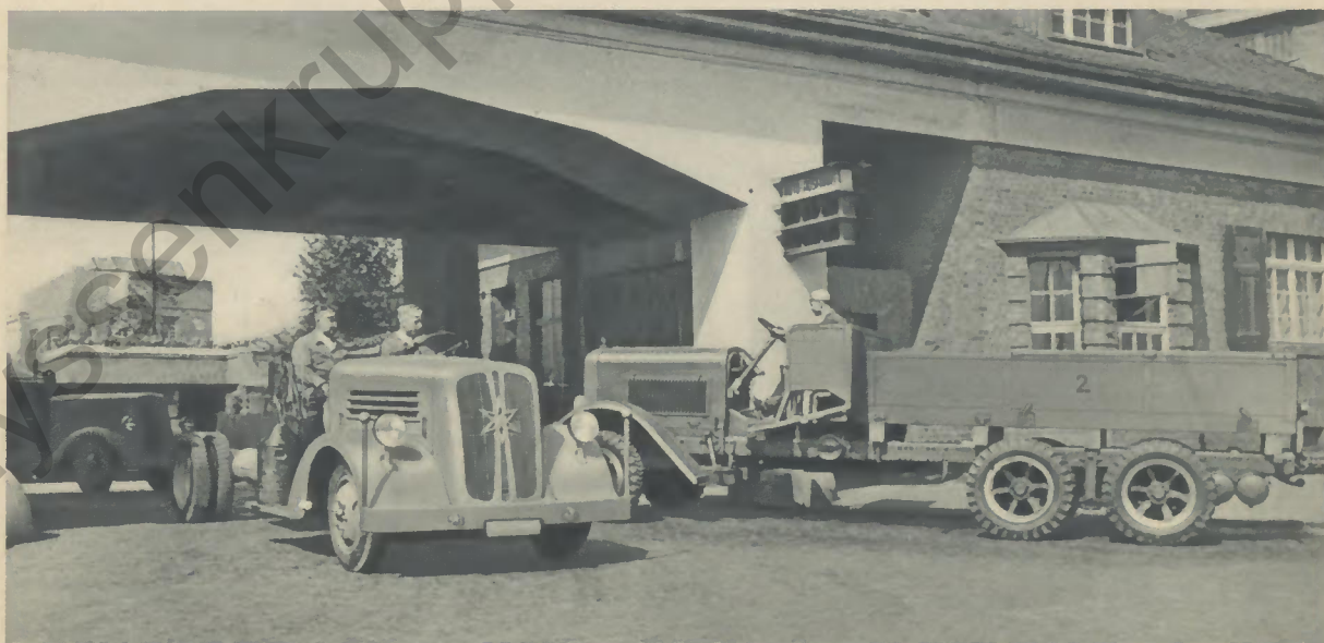
Regel Betrieb vor der Einfahrt zum Kraftwagenwerk
