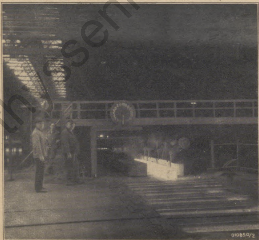
Blockgerüst des Walzwerkes II
