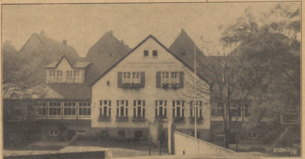
Der Kindergarten an der Elsässer- und Wasgaustraße
