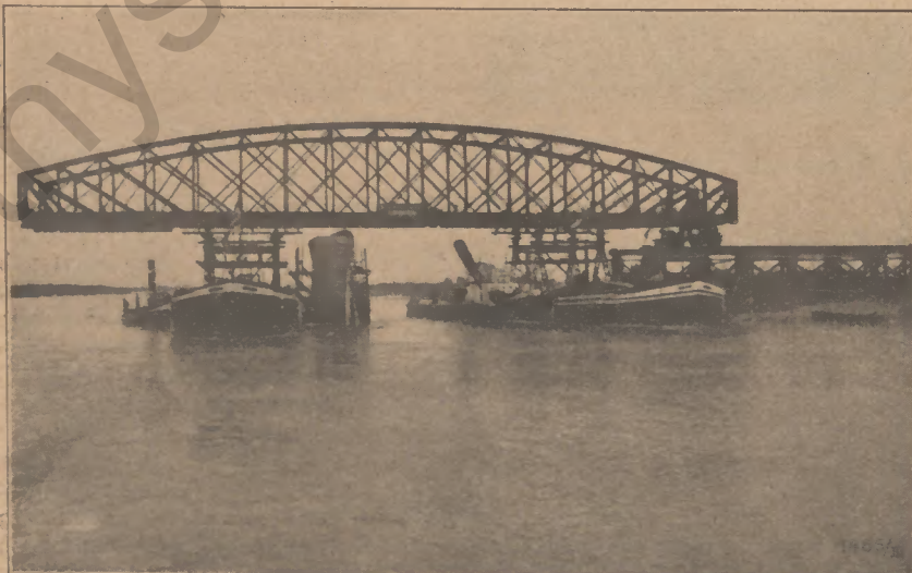
Absetzen des einen Brückenendes auf zwei Verschiebewagen der Längerverschiebebahn 15 Uhr.
