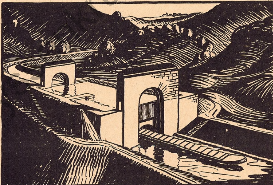
Tauchschleuse Böhmeler im Gelände
