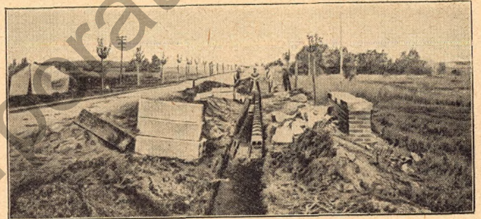
Abb. 5. Bau des Zementkanals
