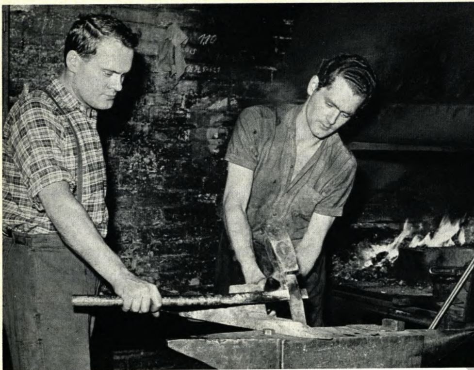
Beim Ausschmieden von Abstreifeisen, sogenannten „Hunden“, in der „Hundeschmiede“ des Walzwerkes der Niederrheinischen Hütte.
