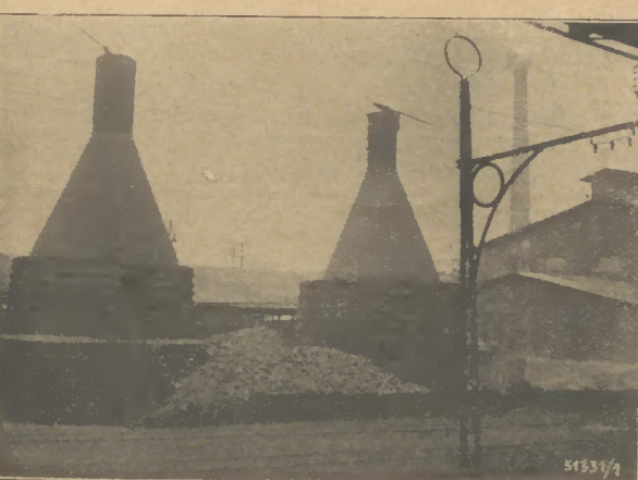
Altdeutsche Schamottebrennöfen (wie sie heute noch bei uns im Betriebe stehen)
