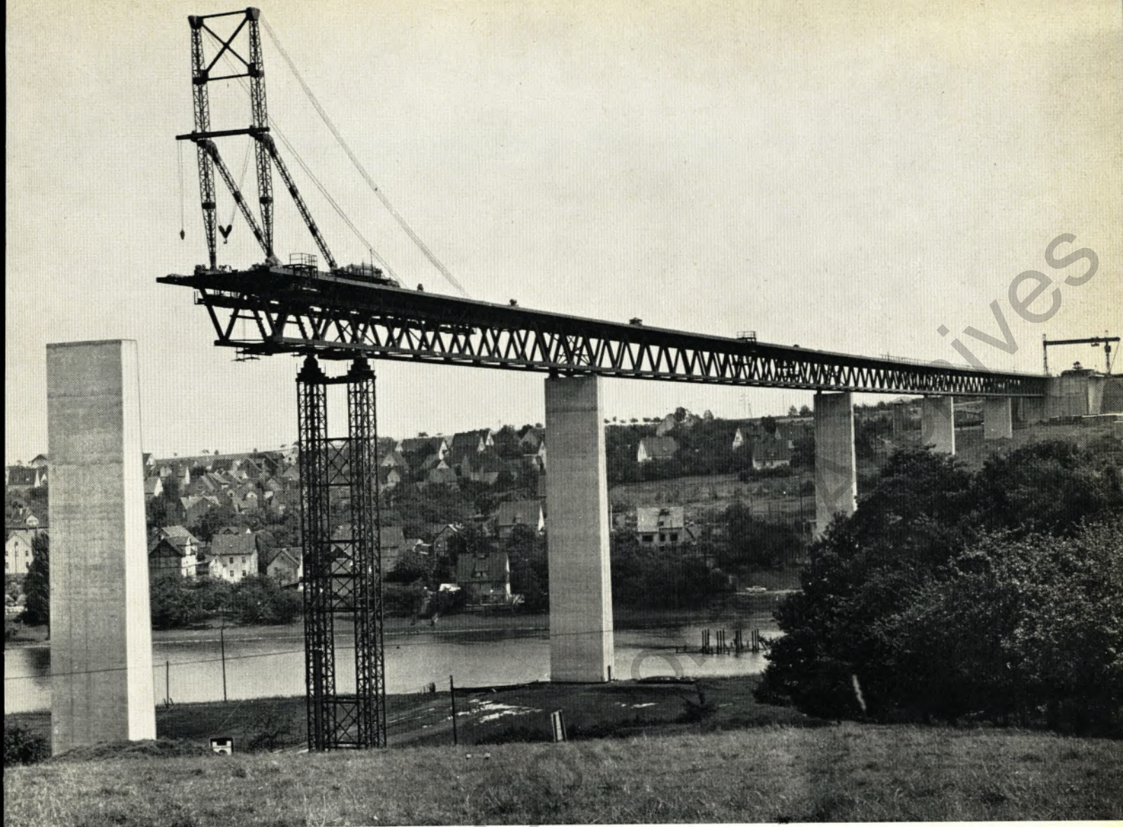
Die neue Brücke über die Fulda bei Kassel ist ein Stück der geplanten Autobahnverbindung vom Ruhrgebiet an die Autobahn Hannover—Frankfurt. Sie führt, in einer bislang einmaligen Bauweise harmonisch in die hessische Landschaft eingefügt, in 50 Meter Höhe über den Fluß.
