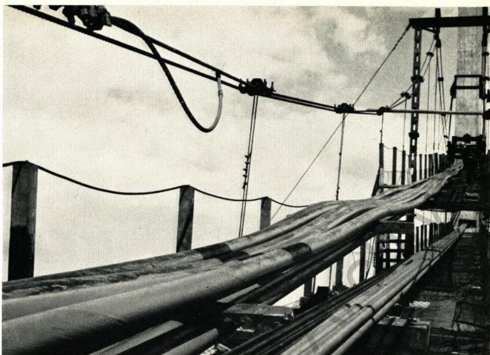
Eine seltene Aufnahme: Die Seile werden gespannt, um die Last der Brücke zu übernehmen.
