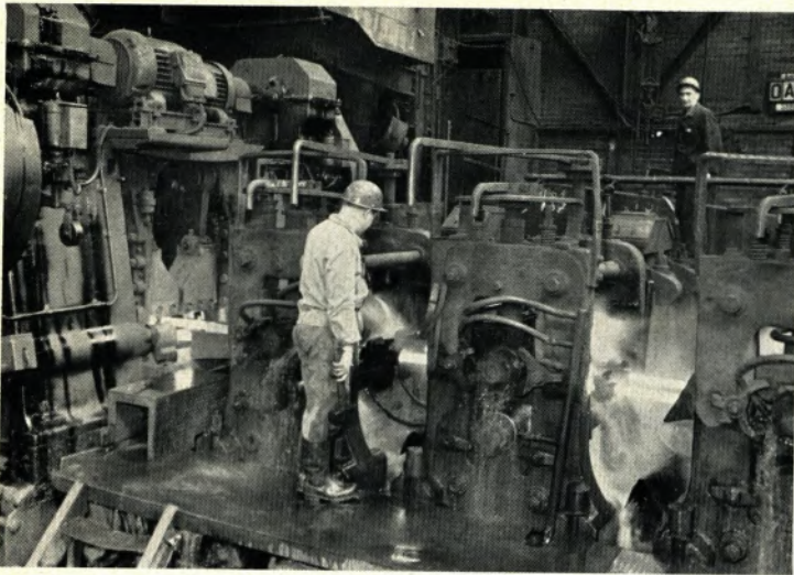
2. Vorstraße von Drahtstraße II und III
