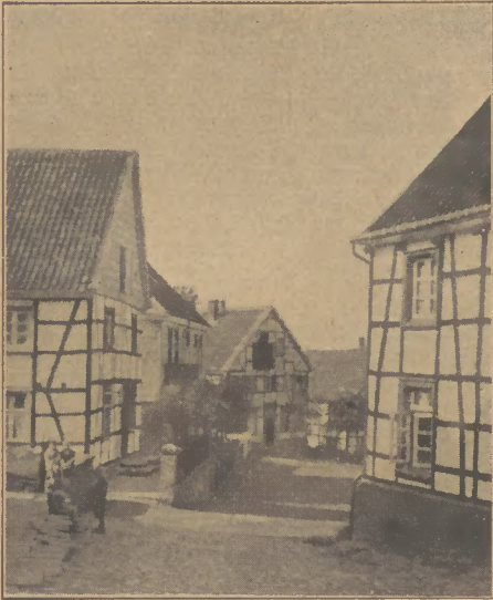
Teilansicht aus der „Freiheit.“ Aufnahme von Carl Klingebiel, Turbinenanlage.
