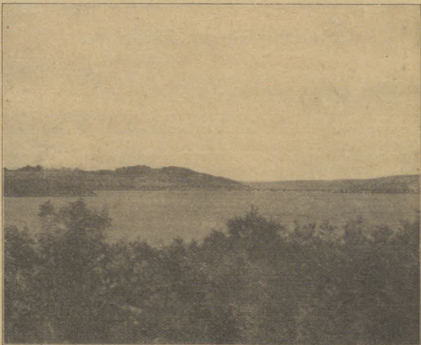
Blick über den See auf den Viadukt von Delecke.
