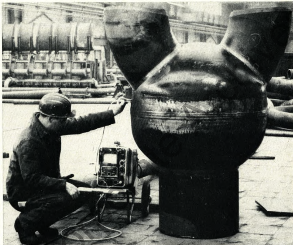
Bei einem Kugel-Y-Stück wird die Schweißnaht mit einem Ultraschallgerät genau nachgeprüft.
