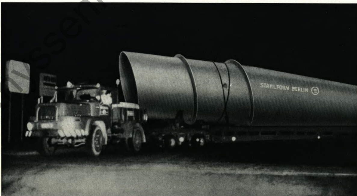
Einer der vier je 24 m langen Mast-Giganten, für deren Transport von der Werks-halle unserer Tochtergesellschaft in Spandau zum Verladehafen durch die nächtlichen Straßen von Berlin Spezial-tieflader verwendet, Straßenbahn - Oberleitungen angehoben und Straßenschilder beseitigt werden mußten.
