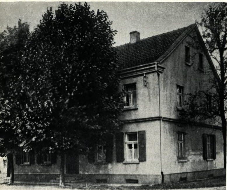
Der von August Thyssen gekaufte Ingenhammshof, vor den Toren des Werkes Hüttenbetrieb gelegen, ist der letzte bewirtschaftete Bauernhof der Ortschaft Lösort
