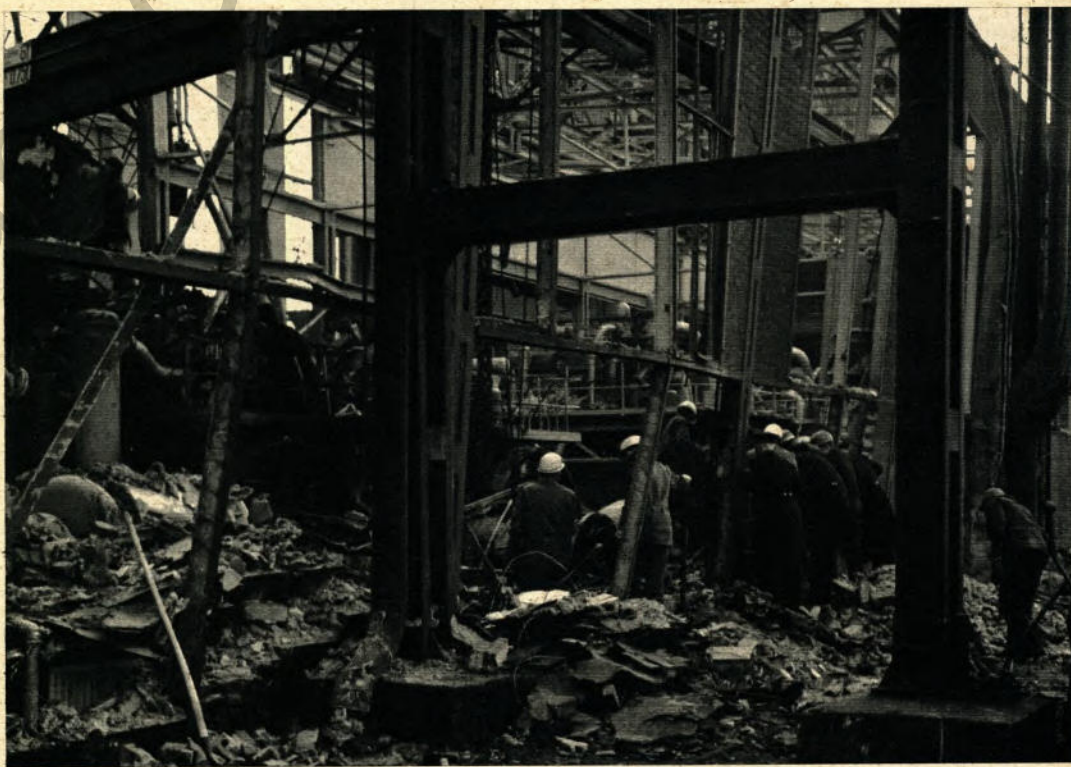
Blick auf die zerstörte Sauerstoffgewinnungsanlage der Knapsack-Griesheim AG, die mitten zwischen den Werksanlagen der Westfalenhütte und der Schachthanlage Kaiserstuhl liegt
