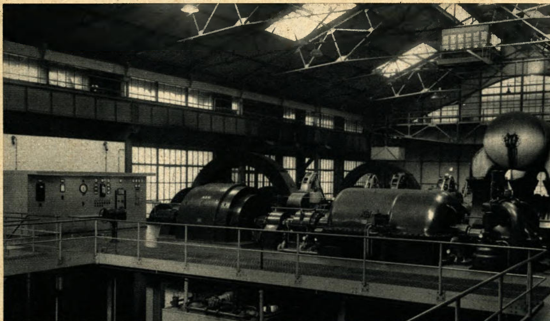
◀ Hochgespannter Drehstrom speist den Hochspannungs-Synchron-Motor, mit dem der nötige Wind für die Hochöfen erzeugt wird
