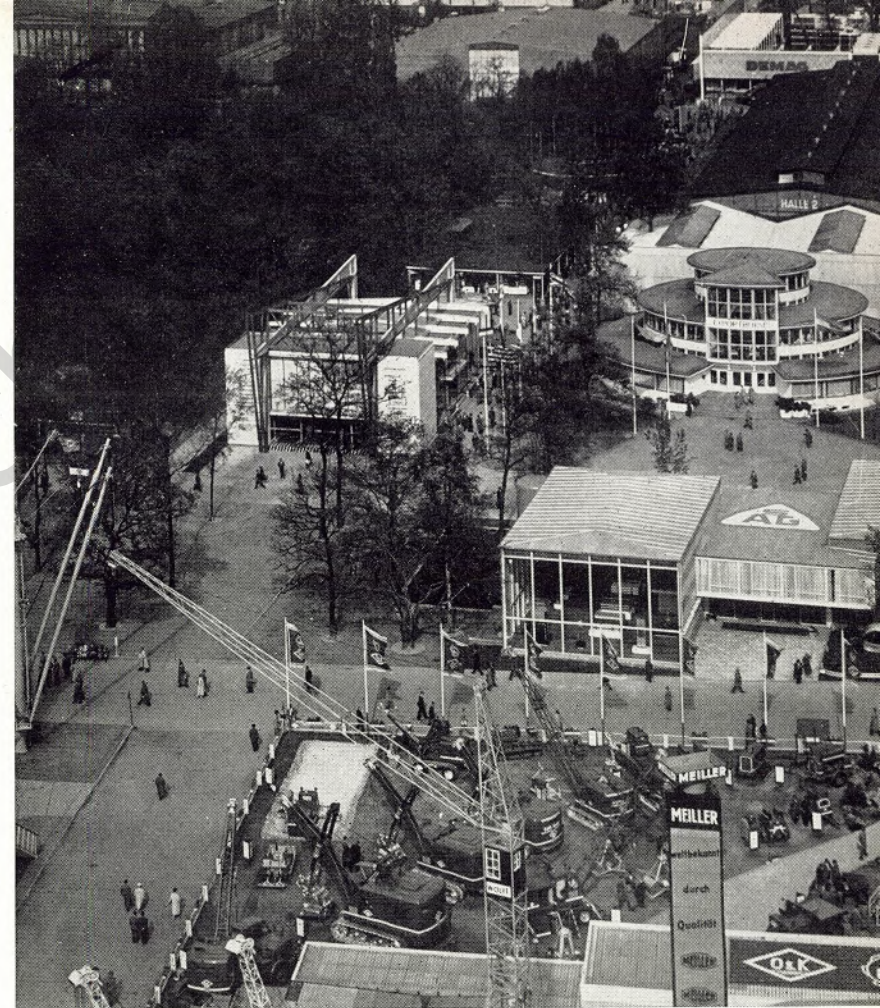
Haus Thyssenstahl auf der Deutschen Industrie-Messe in Hannover — ein neuer markanter Pavillon neben dem Rundbau der Exportbörse — aus 75 Meter Höhe gesehen
