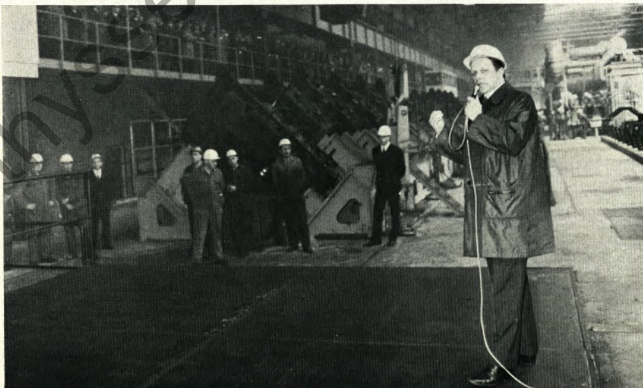
Der Leiter des Mülheimer Werkes Dir. Neuhoff erläutert den Gästen auf dem Besucherlaufsteg den Produktionsablauf in der Rohrkontistraße.
