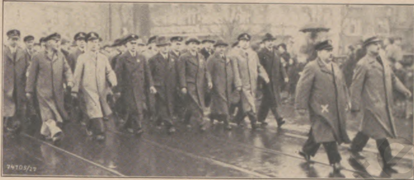
Die Dortmunder-Union-Brückenbau-A.G. auf der Möllerbrücke (X) Dipl.-Ing. Maunterer
