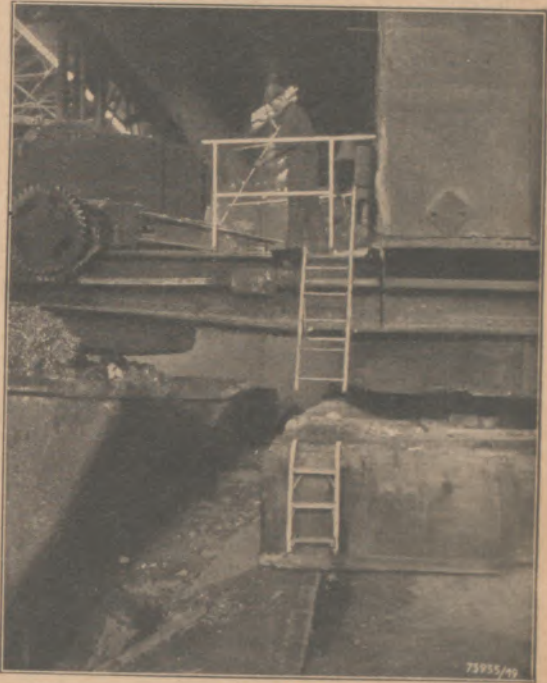
Bild 3: Ständig mitfahrende eiserne Leiter mit Stütze und abnehmbarem Geländer
