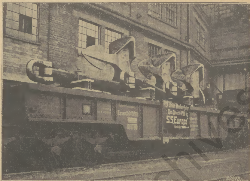
Die auf Tiefadewagen verladenen drei Anker
