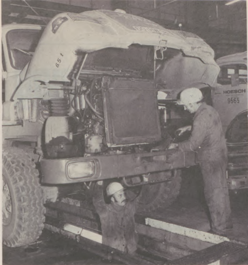
< Reiner Deymann und Klaus Gaca reparieren in der Kfz-Werkstatt Westfalenhütte eine 230-PS-Zugmaschine
