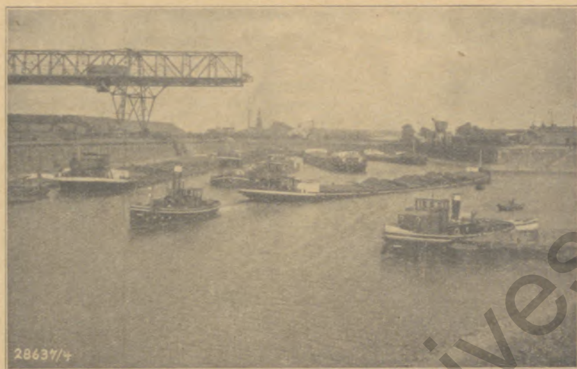
Bild 5: Stichhafen mit Waggontipperbrücke, 55 t Tragfähigkeit
