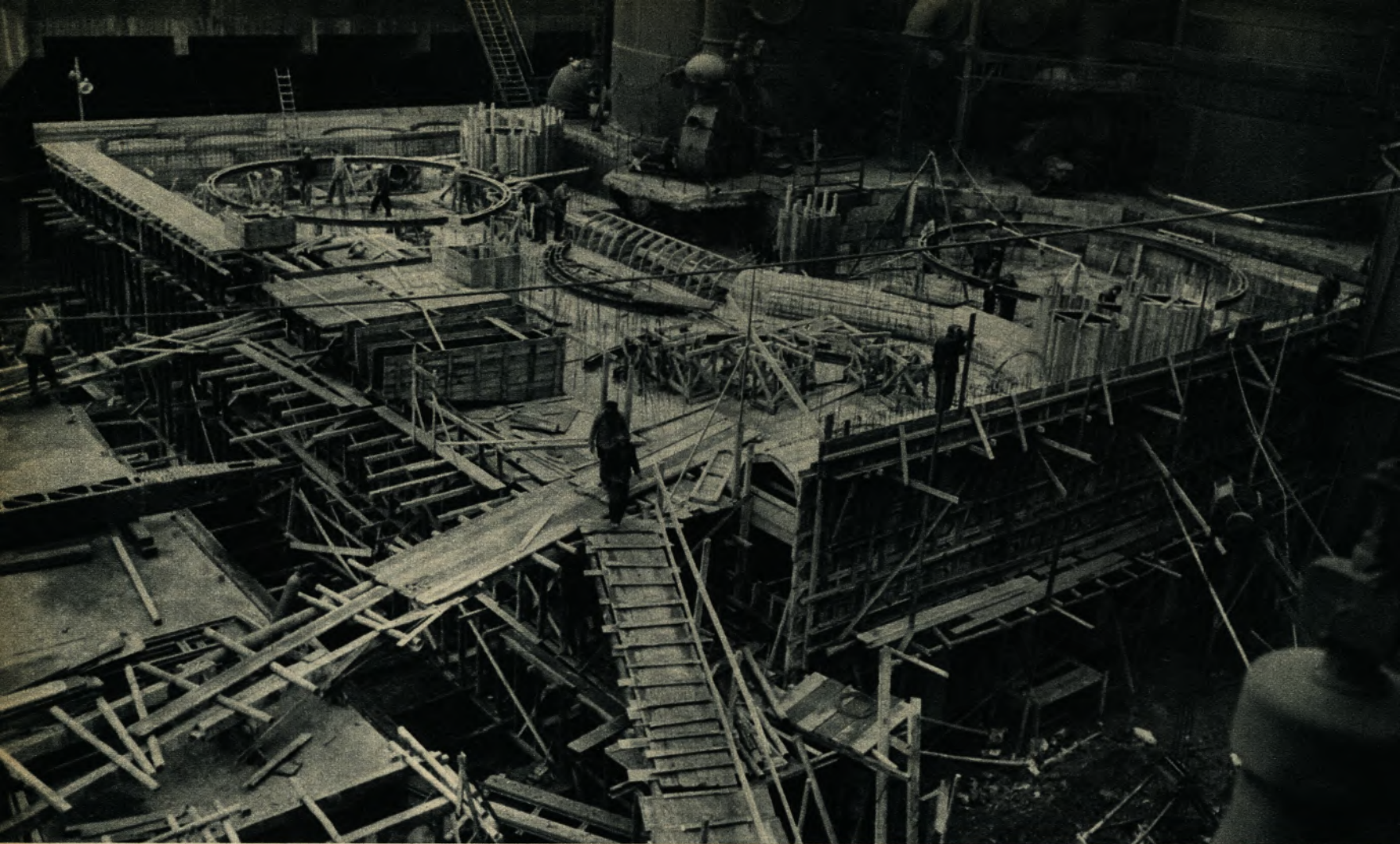
Mitte März 1953 war das Winderhitzerfundament mit der Verankerung der Cowper und dem Rauchgaskanal fertiggestellt. Das Gewicht allein dieses Fundaments, dessen Wandstärke 2 Meter beträgt, beläuft sich auf schätzungsweise 7000 Tonnen. Die Hohlräume des Fundaments wurden als Luftschutzbunker ausgebaut. Unten: Mitte April befand sich das Ofengerüst in der Montage. Im Gerüst ist der Gestellpanzer mit dem ersten Schuß des Schachtmantels, der von den Löchern für die Kühlkästen durchbrochen wird, sichtbar.
