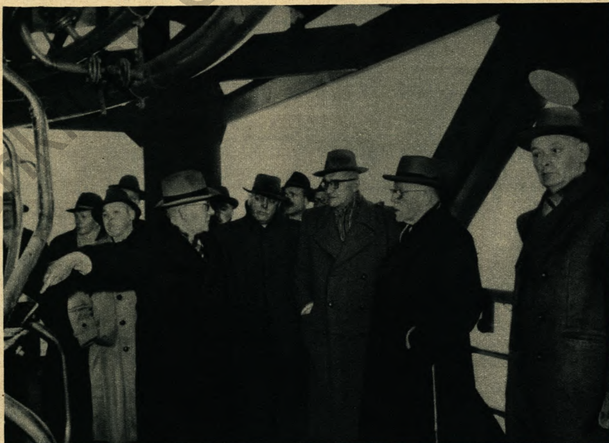
Am 4. Januar dieses Jahres konnte der neue Hochofen angeblasen und damit in Betrieb genommen werden. Die Aufsichtsräte der Hoesch Werke AG und der Westfalenhütte AG besichtigten an diesem Tage den neuen Hochofen. Unser Bild zeigt Mitglieder der Aufsichtsräte auf der Hochofenbühne.
