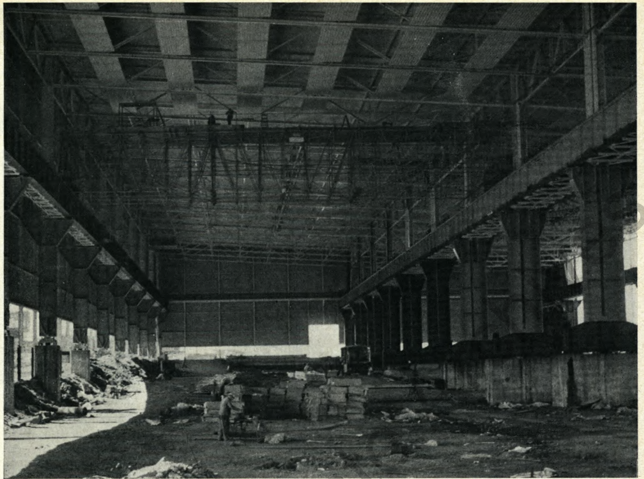
^ Fahrbare Hilfsgerüste ermöglichen die Montage im Hallenbereich.
