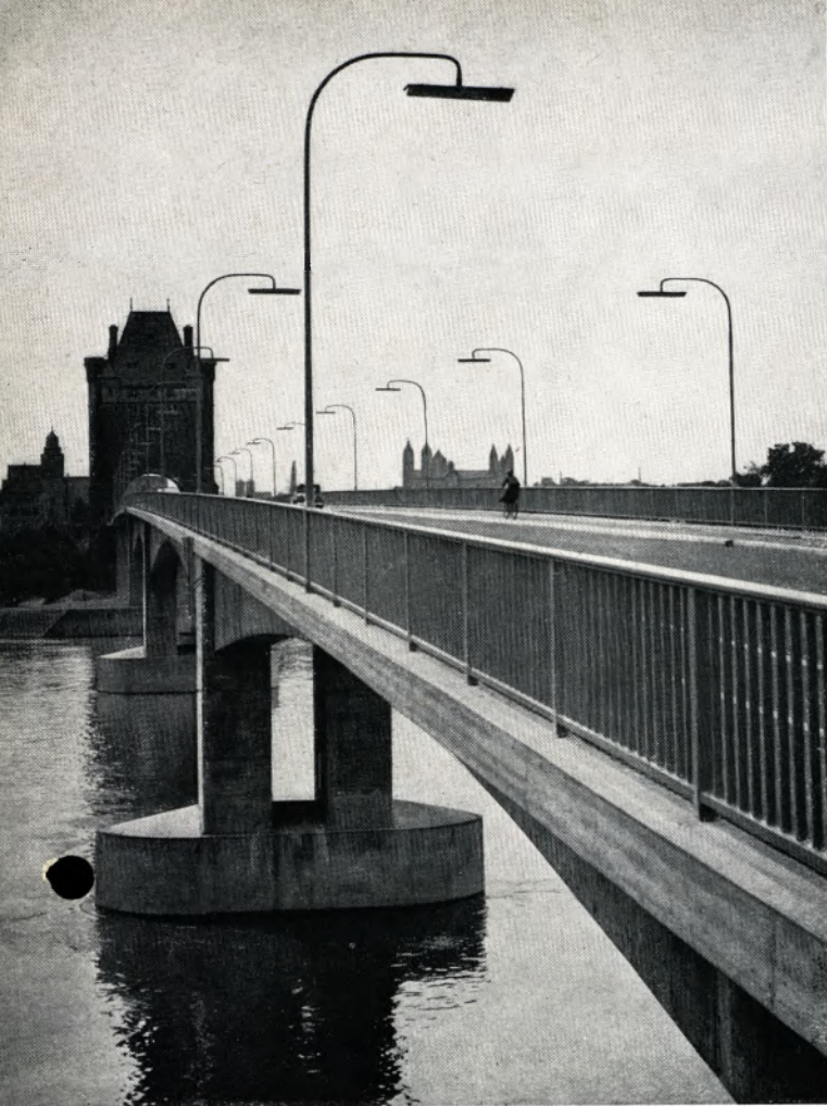
Die Nibelungen-Brücke in Worms wurde nach ihrer Fertigstellung im Sommer mit Lichtmasten vom Werk Dinslaken bestückt.
