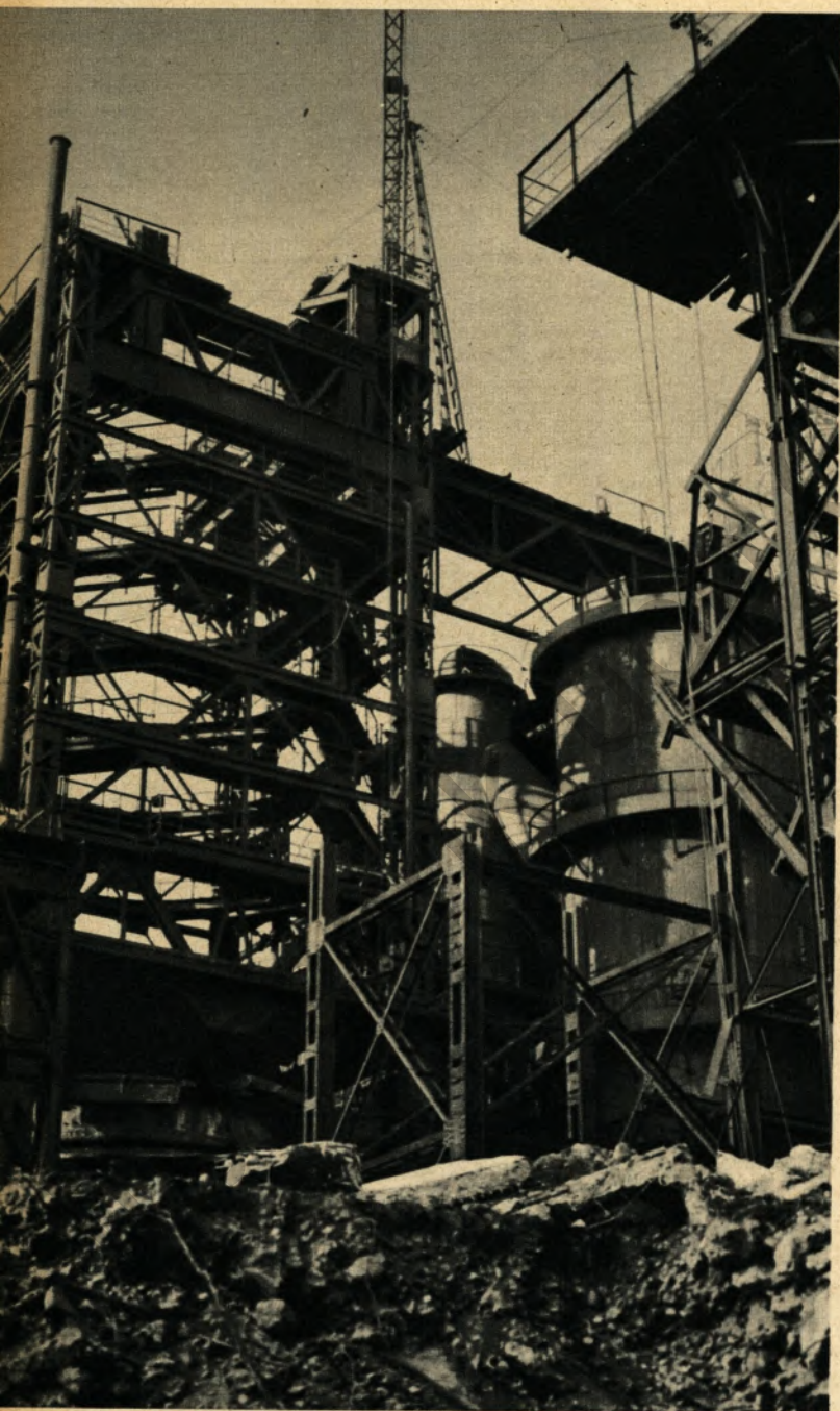
Der Hochofen IV der Westfalenhütte wird zur Zeit neu zugestellt.
