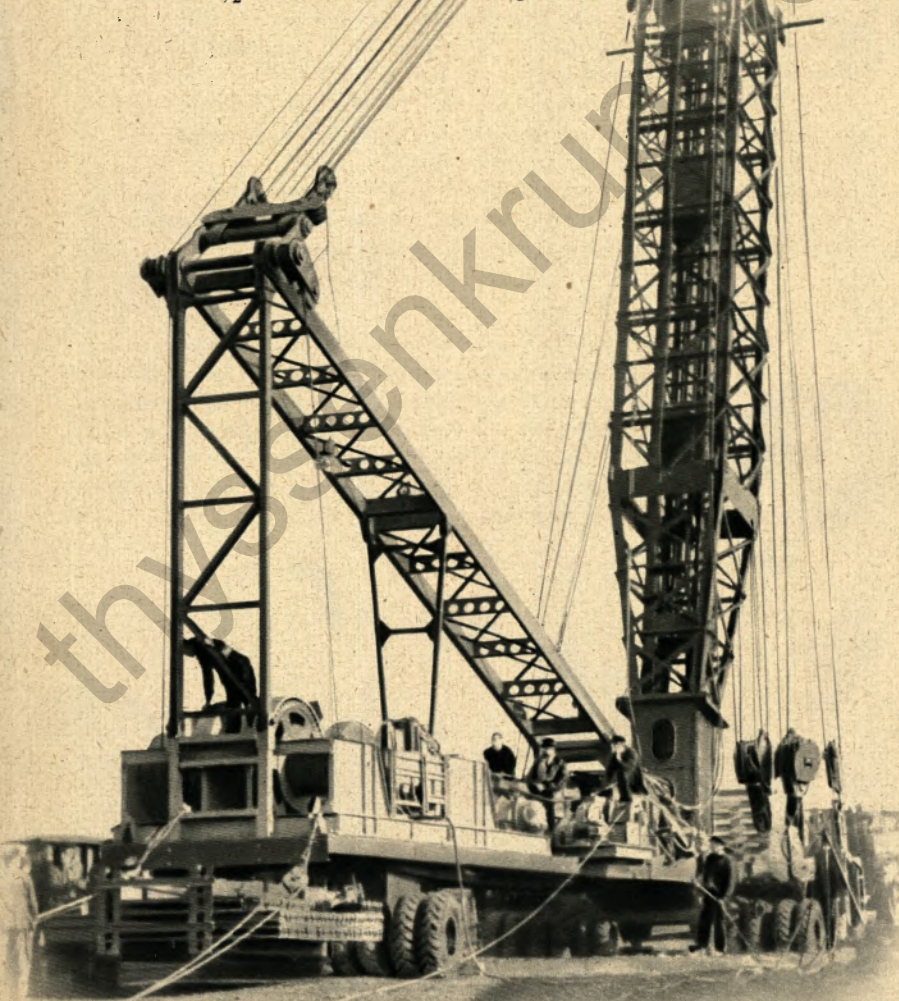
Bild links Dieser Montagekran ist etwas ganz Neues! Er kann ähnlich wie eine Feuerwehrleiter ausgezogen werden. Eingefahren ist der Mast 27,5 Meter hoch, ausgefahren 42,5 Meter! Dieses Großgerät hebt bis zu 150 Tonnen schwere Lasten!
