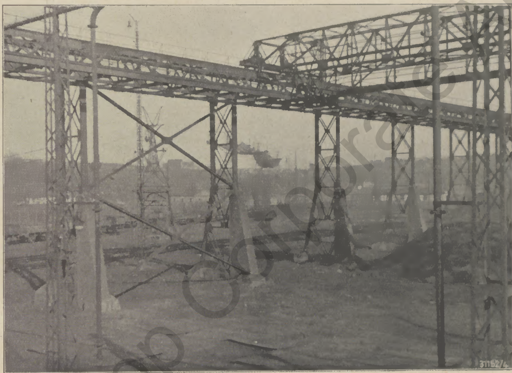
Kohletransport-Anlage der Heinrichshütte am Zentralkesselhaus
